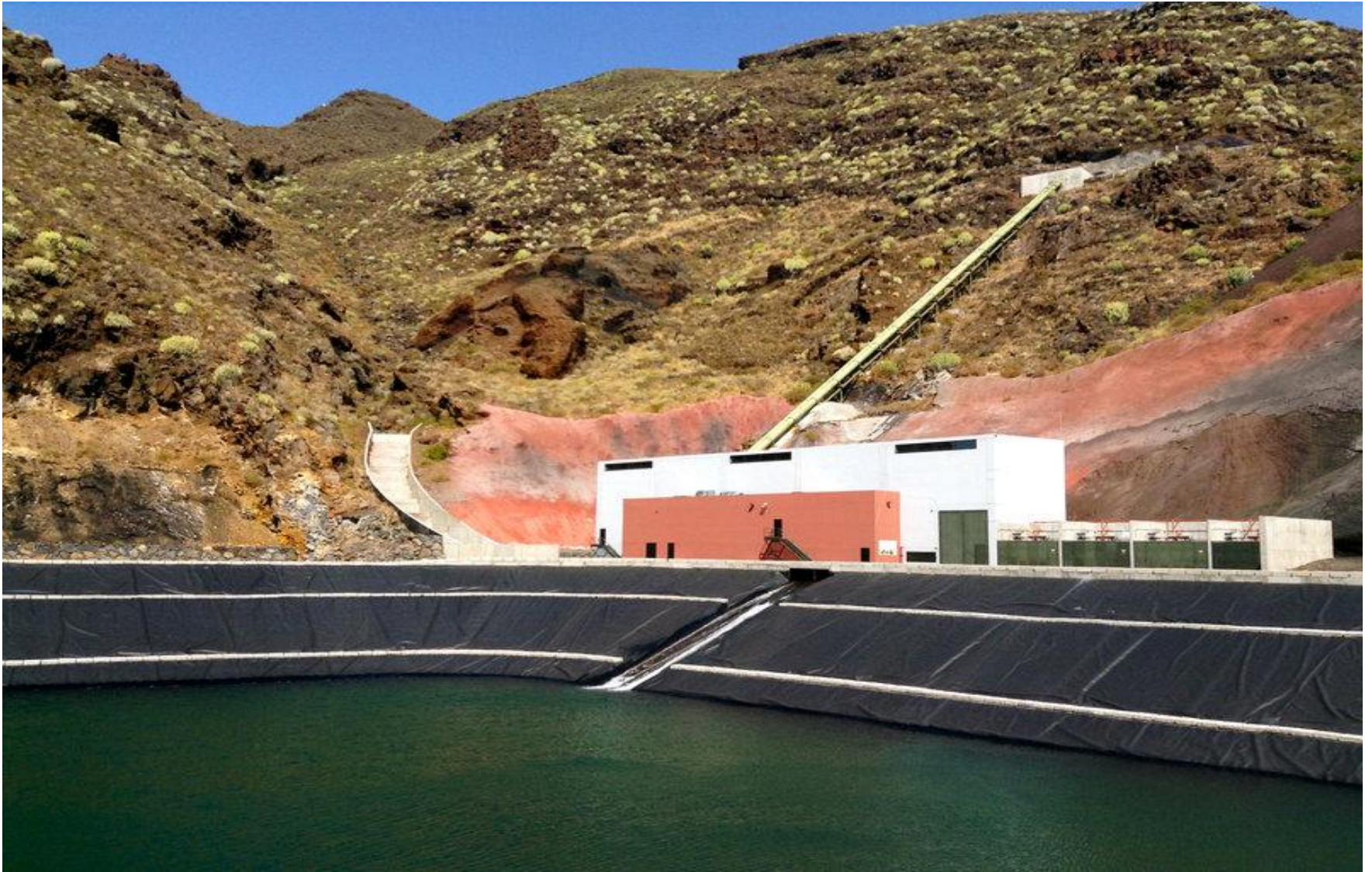
El Hierro: Wind and hydro
